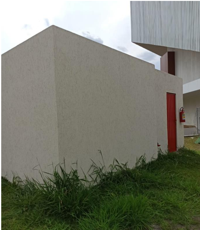
Foto 1 – Casa de bomba Igreja
