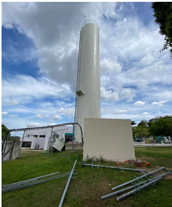
Foto 4 – Casa de bomba Reservatório
