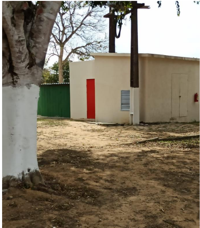
Foto 2 – Casa de bomba CAB
