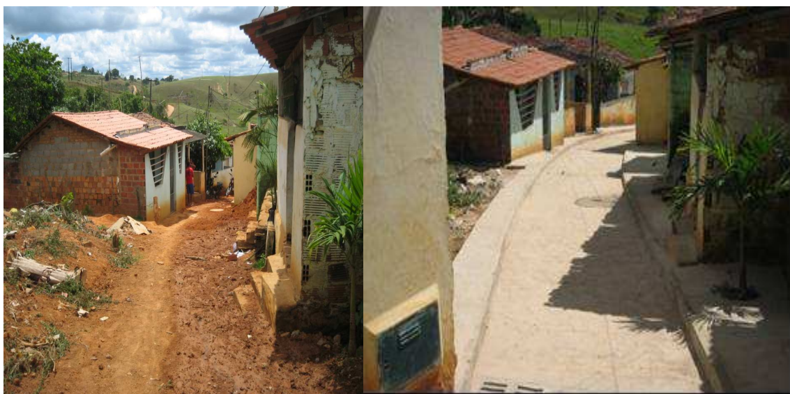
Pavimentação em paralelepípedo
